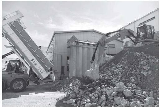
写真2 中間処分場での無筋コンクリートガラの受入れ
