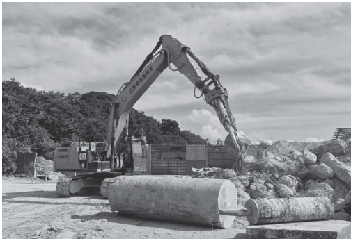
写真1 中間処分場での特大コンクリートガラの破碎
