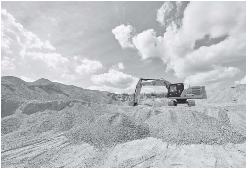
写真3 再生砕石ストックヤード
