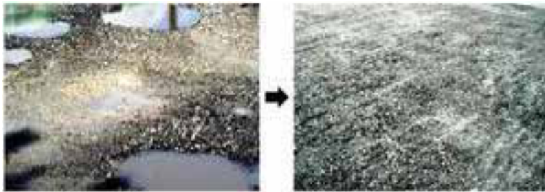
砂利敷き駐車場のくぼみを再生砕石で埋める
